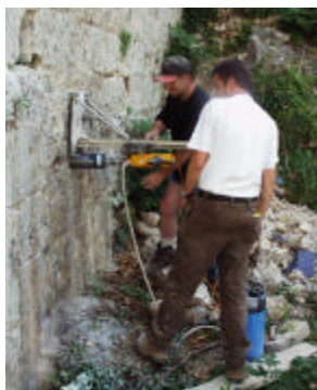
Probenentnahme vor Ort
