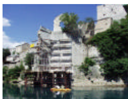
Die Brücke nach der Zerstörung
