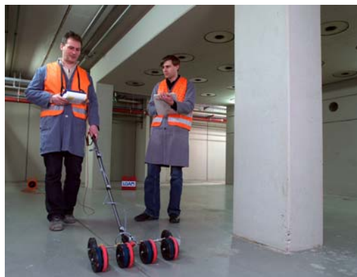
Einsatz des Messgerätes mit Vier-Radsonde
