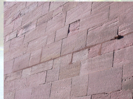
Bild 1: Überwachung der Stadtmauer Nürnberg
